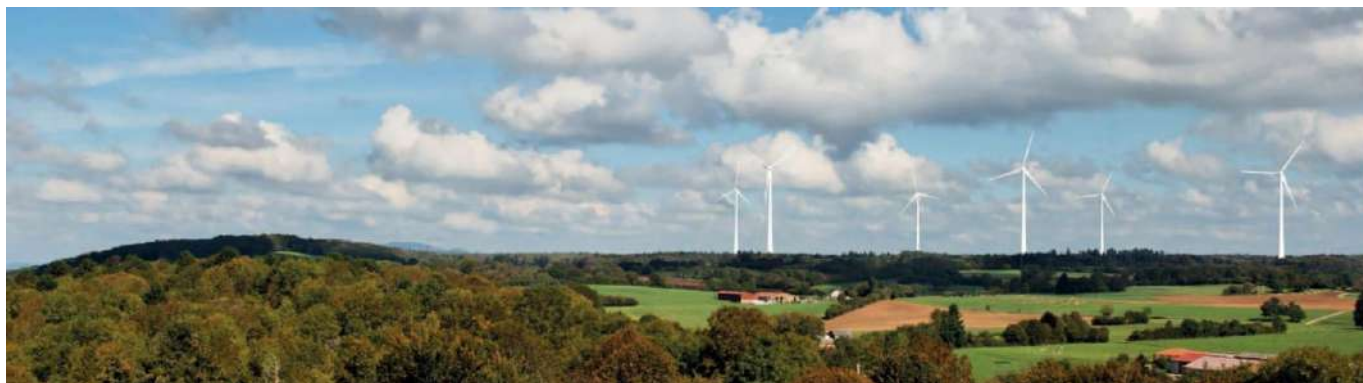
Figure 7 : Parc éolien de Chamole (18MW) construit en 2017 (Source : Intervent)
