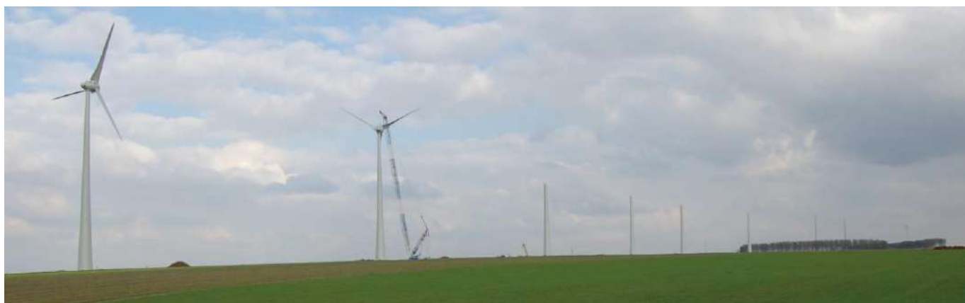
Figure 8 : Travaux du projet « Le Nouvion », parc de 24 éoliennes (Source : Intervent)
