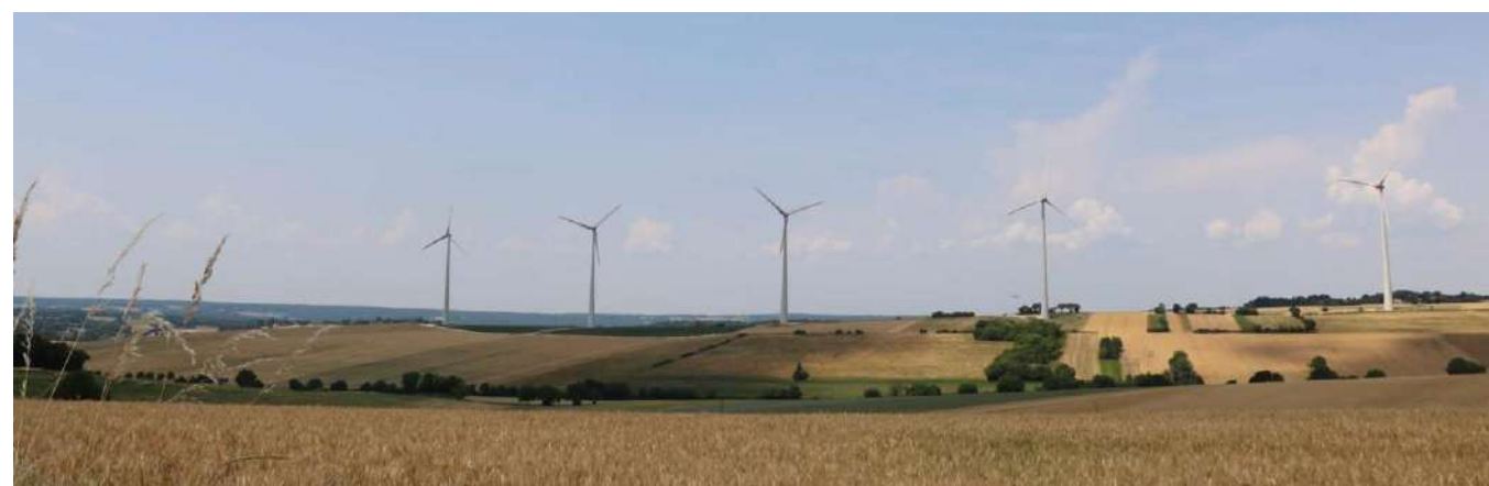
Figure 6 : Parc éolien de Bouhy (11,5MW) construit en 2017 (Source : Intervent)
